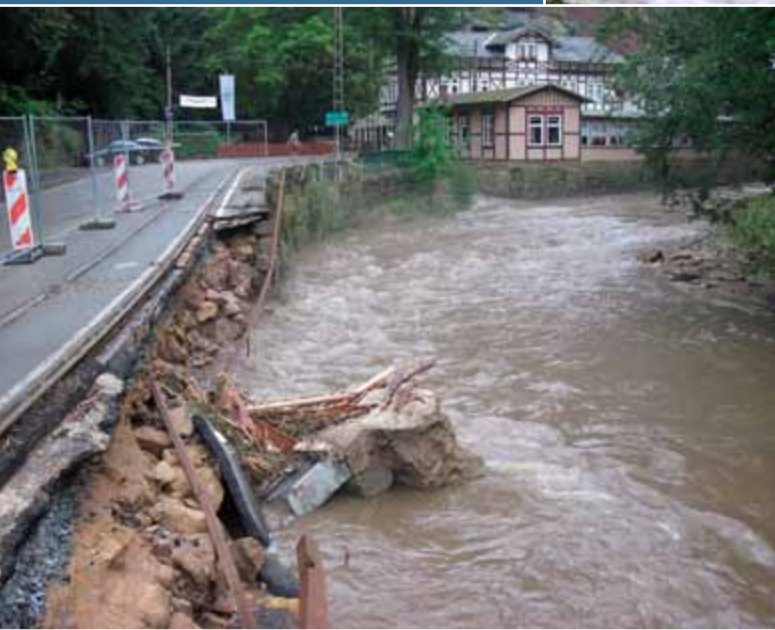
▲ Stav tratě čtyři dny po vylití řeky Křinice v úseku mezi stanicemi „Lichtenhainer Wasserfall“ (restaurace v pozadí) a „Beuthenfall“. Zde byl tramvajový provoz na dva a půl roku zastaven pro nutnou rekonstrukci tratě (12. 8. 2010).
