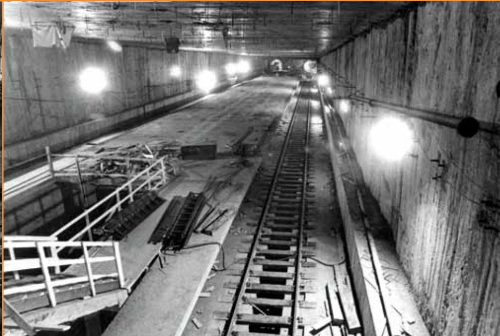
▼ Jedinou hloubenou stanicí prvního úseku trasy A je dnešní Dejvická. Tady je ještě v hrubé stavbě.
