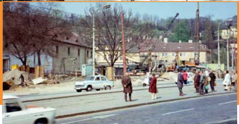
▶ Hloubení podzemních stěn na stanici Malostranská (6.4.1974).
