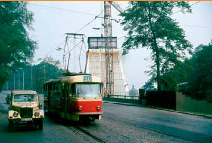
▲ Pro stavbu trati A byly charakteristické těžní věže, jimiž se vytěžená zemina odvážela na povrch. Jedna z nich stála v Chotkově silnici (kolem 1975).
