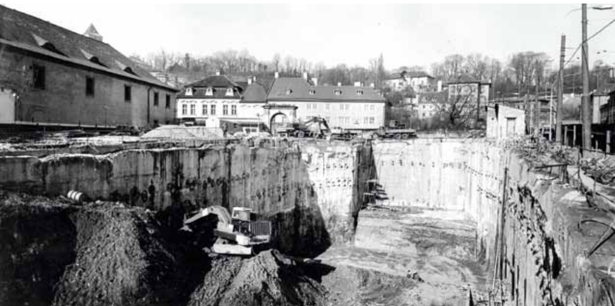
◀ Stavební jáma vestibulu stanice Malostranská (1975).
