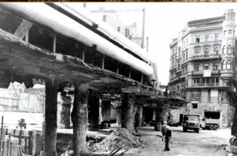
Stavba podchodu na Můstku (1976). ▲
