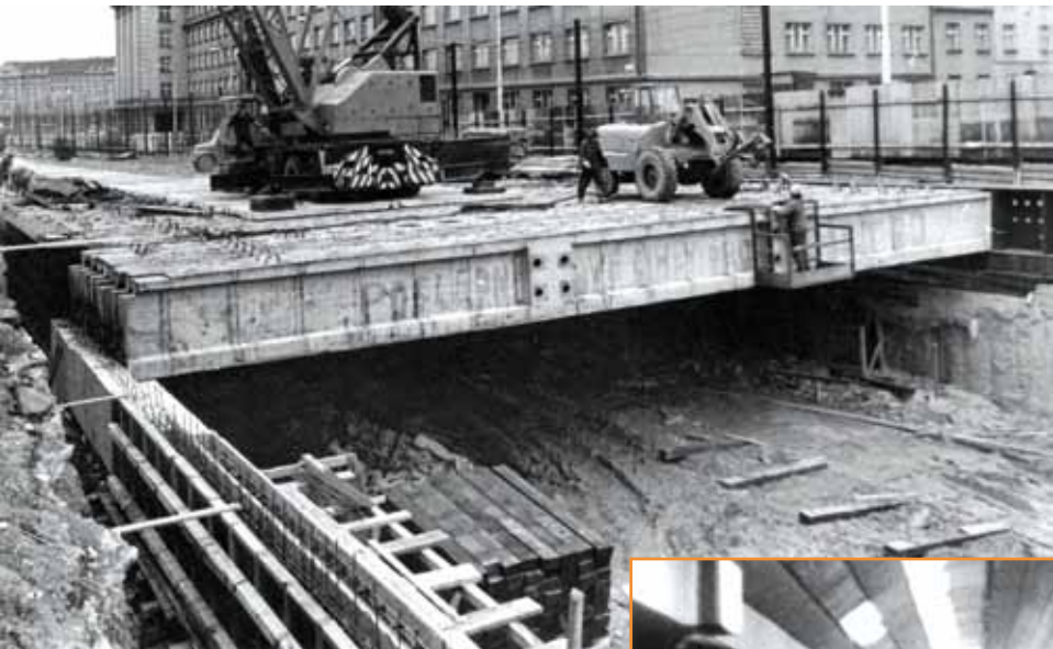
▲ Zakrývání stropu stanice Leninova (1975)
