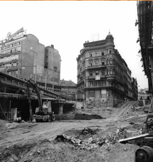
▲ Stavební jáma na Můstku, tady vyroste podchod a také vestibul stanice Můstek, pohled směrem do ulice 28.října (1976).
