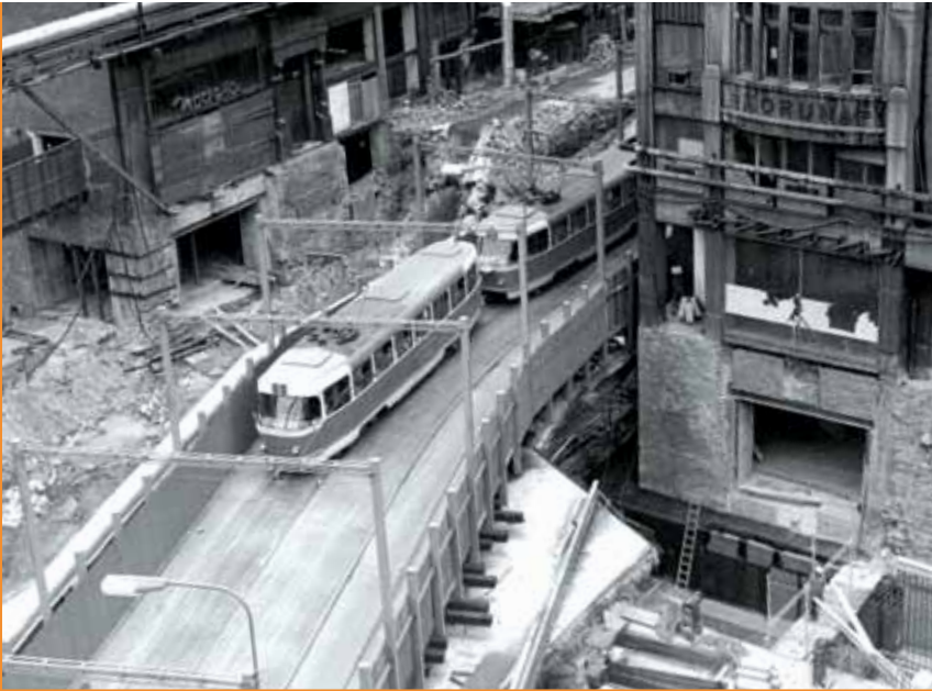
◀ Při stavbě musel být postaven pro tramvaje provizorní most, který vynikne při pohledu shora. V provozu byl v letech 1976-78. Od 4.července 1985 tudy již tramvaje nejezd.
